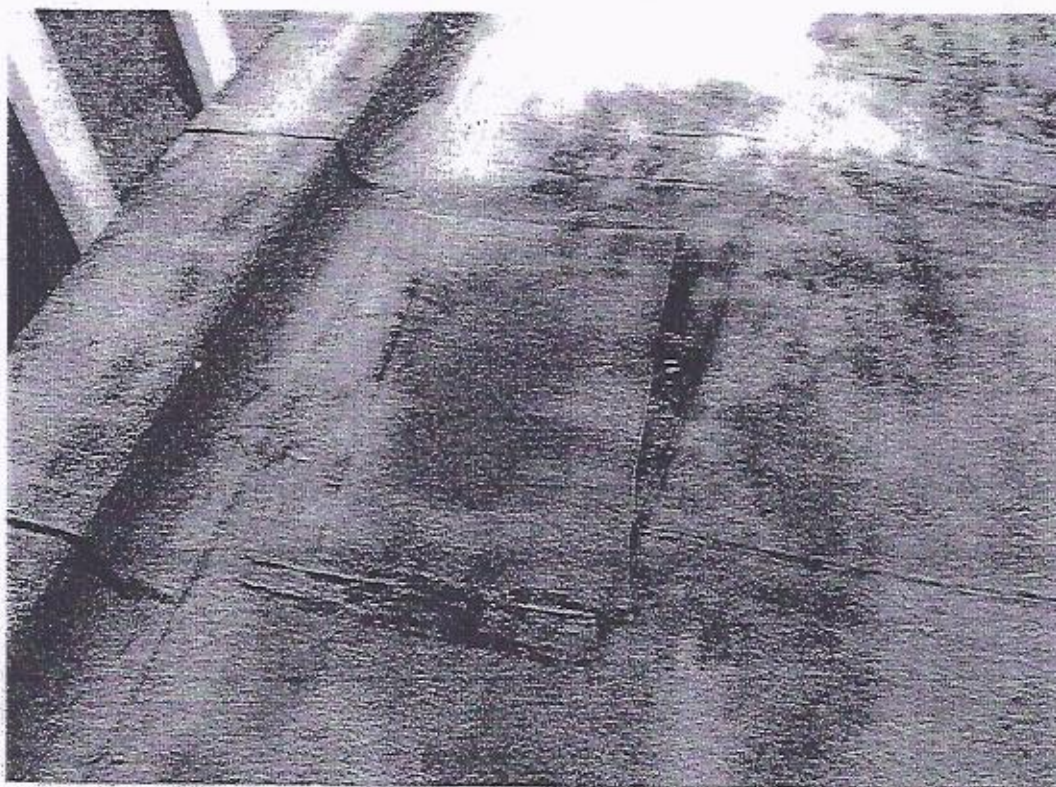
Lokálne opravy netesností strešného plášťa
